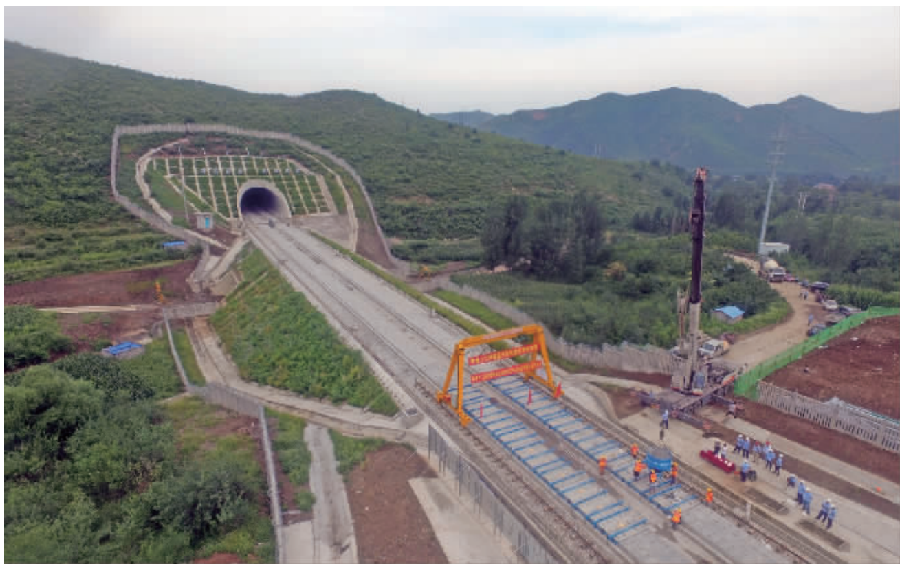
12日,在京沈高铁辽宁段凌源同盛隧道工地,中铁十二局工程技术人员准备向轨道板灌注混凝土
