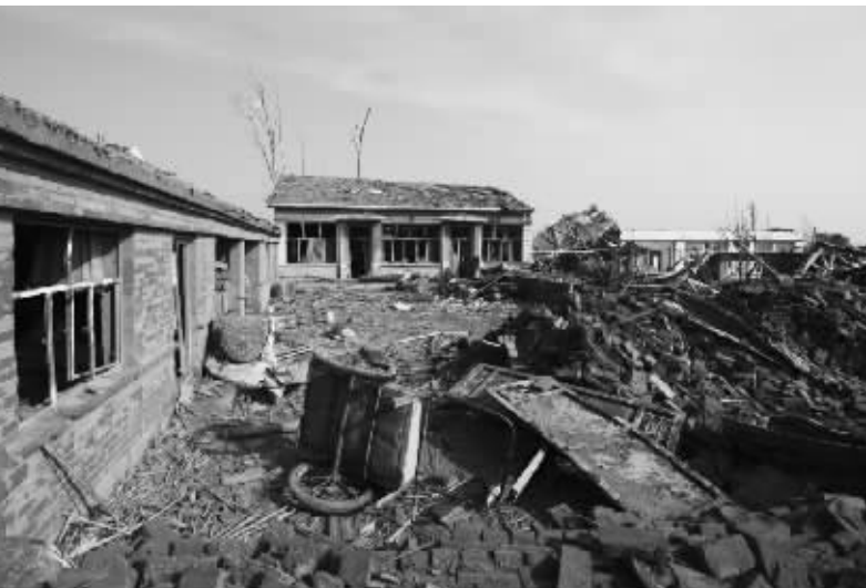
内蒙古克什克腾旗土城子镇五台山村一民居受损
